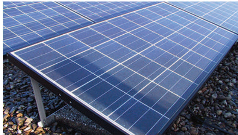
Ilustración 26 Ejemplo de módulos FV con sombras como consecuencia de árboles (Fuente: DGS Berlin e. V.)
