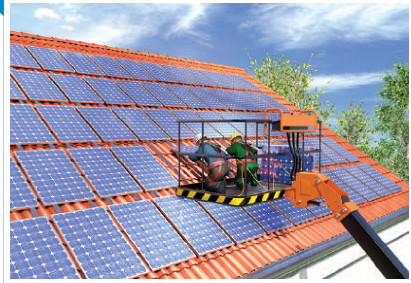
Ilustración 16 Plataforma elevadora y equipo de protección personal (Fuente: H.ZWELIS GmbH)
