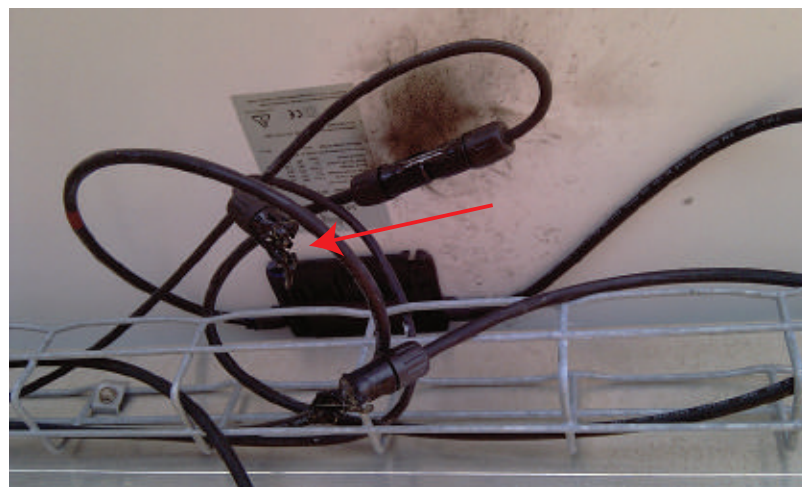
Ilustración 49 Conectores quemados por mala conexión (Fuente: DGS Berlin e. V.)
