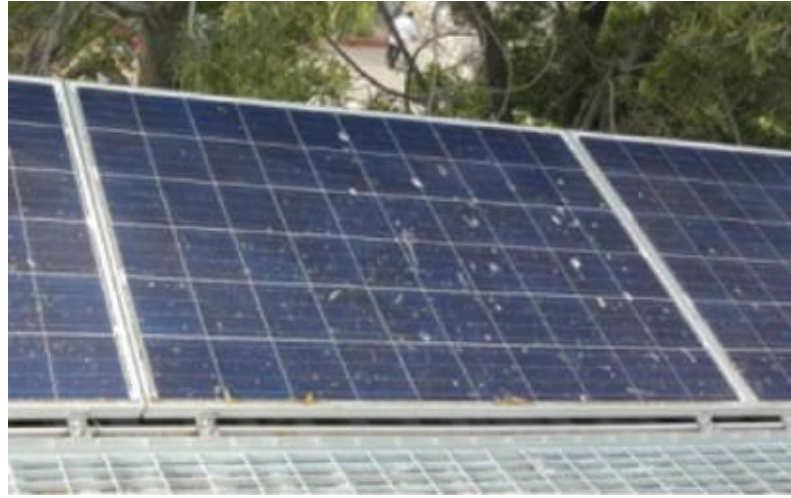
Ilustración 21 Ejemplo de un módulo con acumulación de polvo (Fuente: DGS Berlin e. V.)
