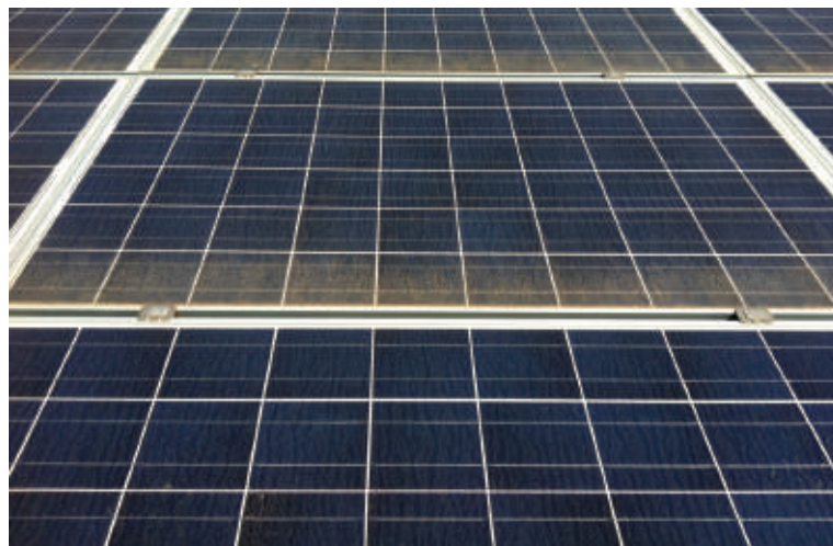
Ilustración 21 Ejemplo de un módulo con acumulación de polvo (Fuente: DGS Berlin e. V.)
