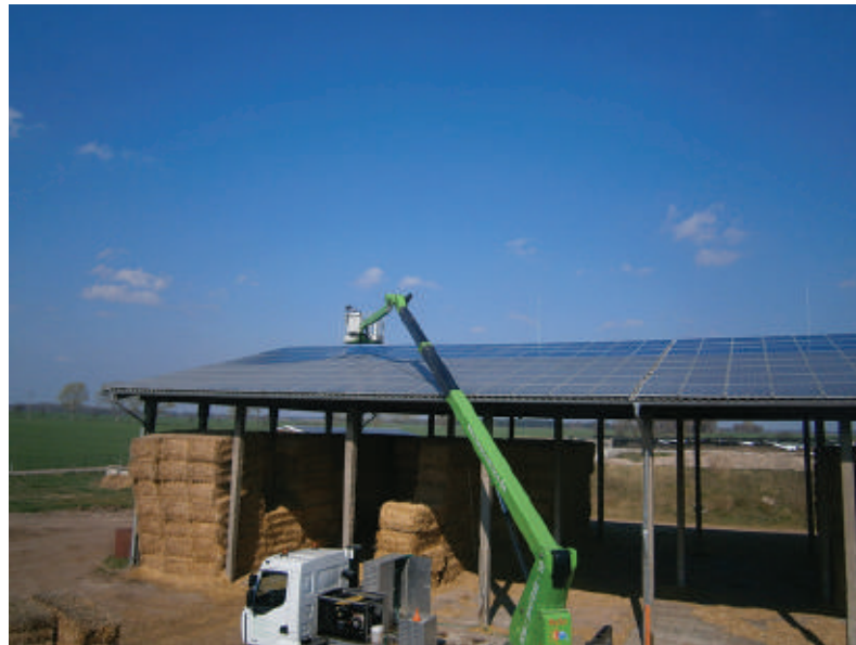
Ilustración 23 Limpieza con plataforma elevadora (Fuente: BeSo Service GmbH & Co. KG, Berlin)
