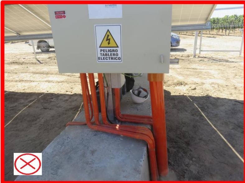
1. Se utilizan tuberías de PVC expuesta directamente a la radiación solar (**RGR 02/2017, numeral 11.4**).
