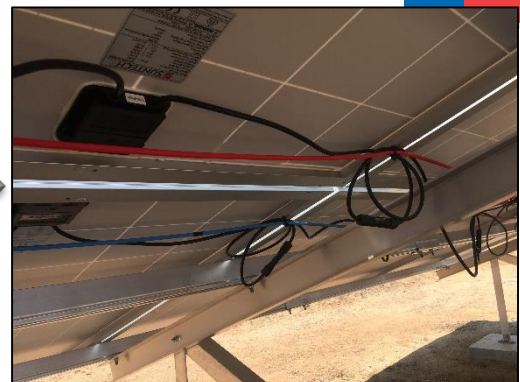
Orden de cableado
