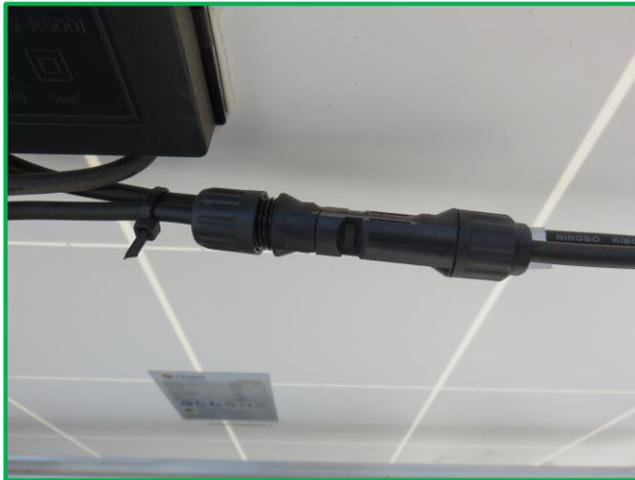
Designación H1Z2Z2-K o equivalentes en conformidad con la norma UNE-EN-50618
